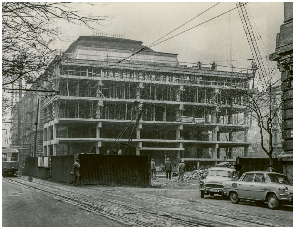
Obr. 5. Prístavba SND počas výstavby, 1971–1972, foto J. Vavro. Archív SND.
