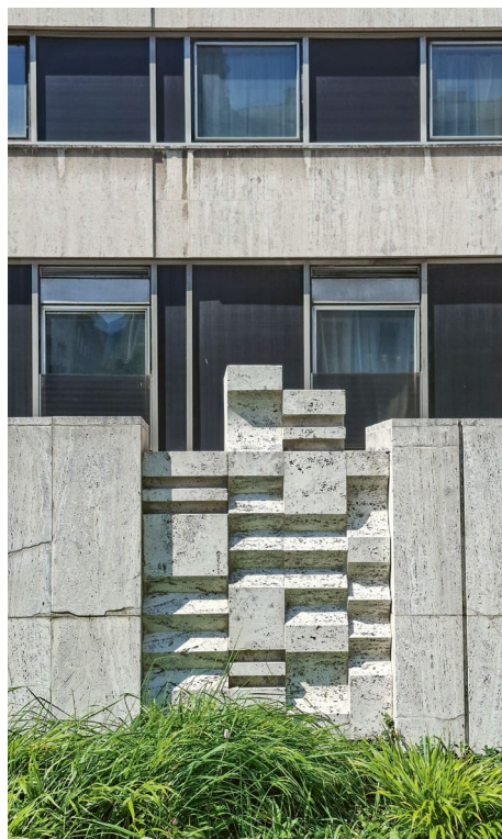
Obr. 11. Reliéf pred vstupnou časťou do prístavby SND, 2025, foto K. Haberlandová.
